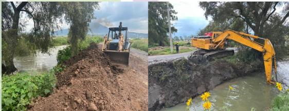
Fotografías 13-14. Trabajo realizado en el río las lajas
